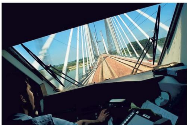
I treni corrono. Le infrastrutture inseguono
