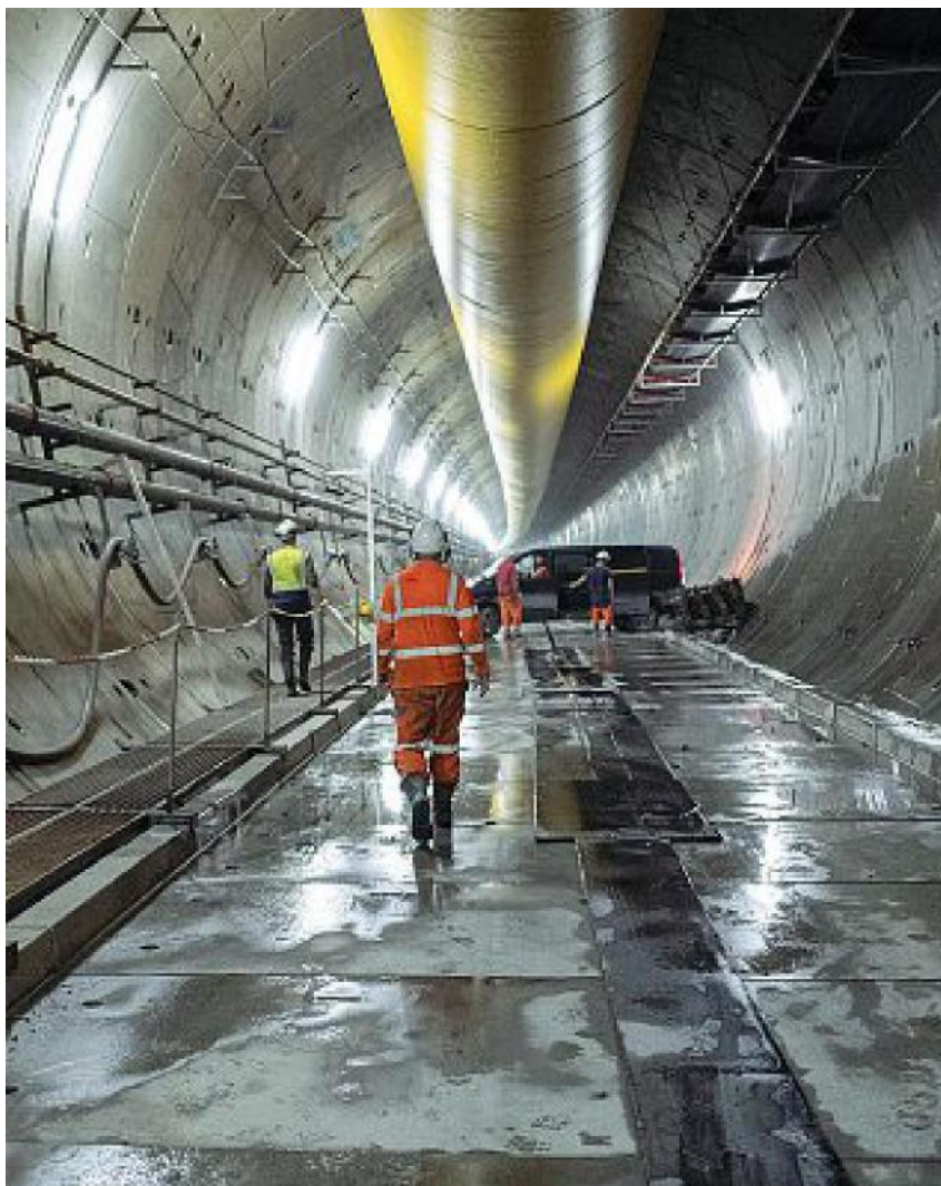
Investimenti e cantieri Uno tra i nodi centrali per la ripartenza anche economica di Torino
